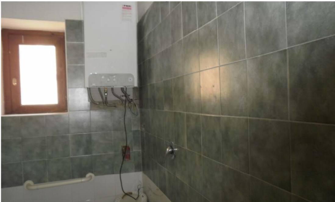
Foto n°5 : Particolare bagno da ristrutturare
